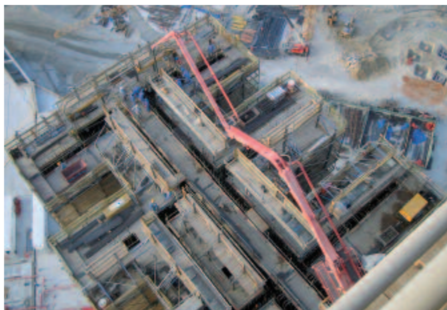
Même les mâts stationnaires PM sont conçus comme une flèche à pliage en Z
