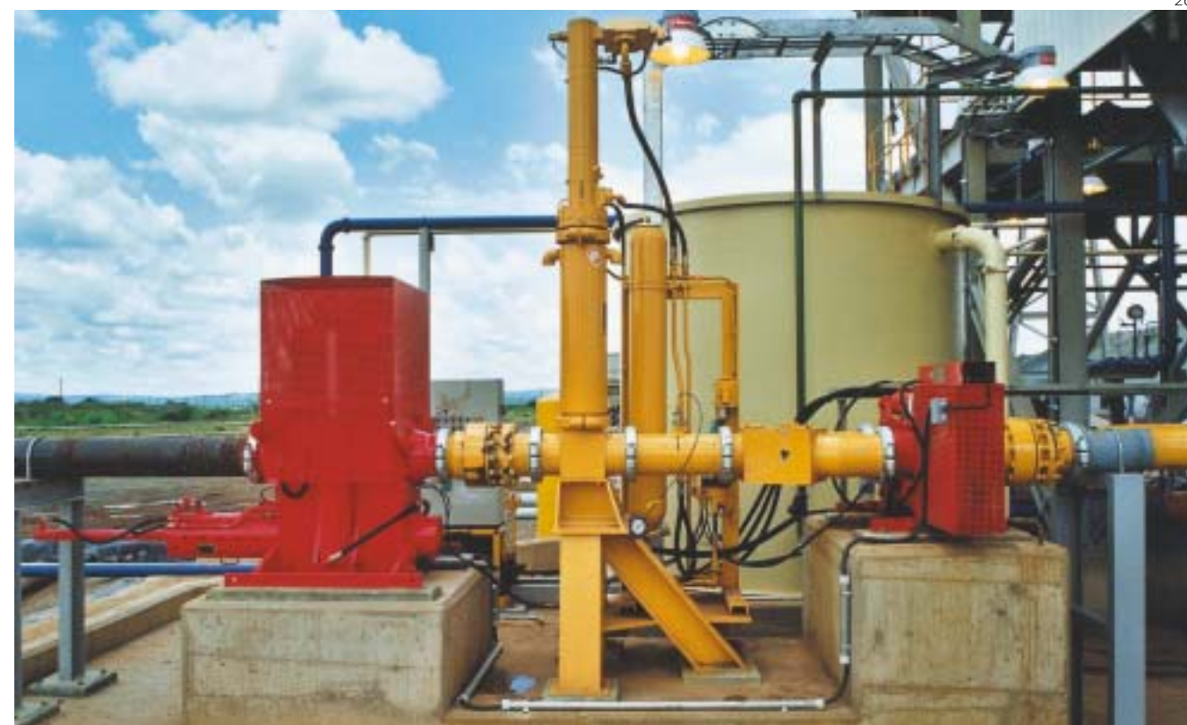
Aiguillage ZX 200. Amortisseur haute pression HPD 200/750 et répartiteur DVH 412.
