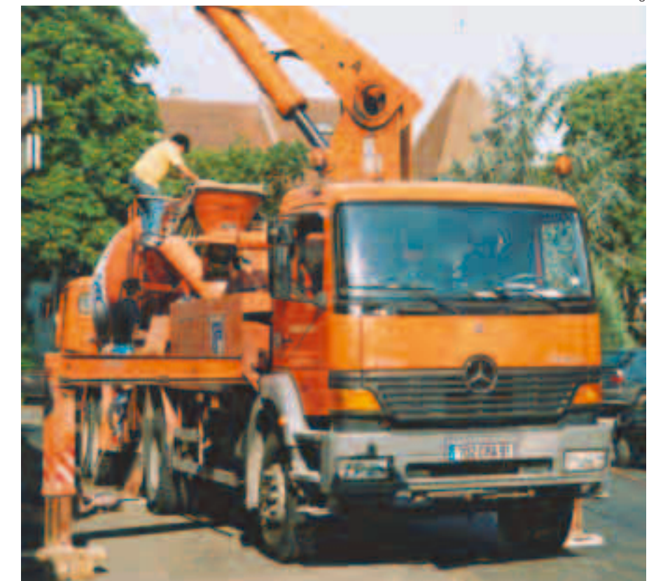
La BOF 24.08 peut être installée sur la route sans trop gêner la circulation
