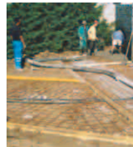
Les tuyauteries sont disposées autour du bâtiment
