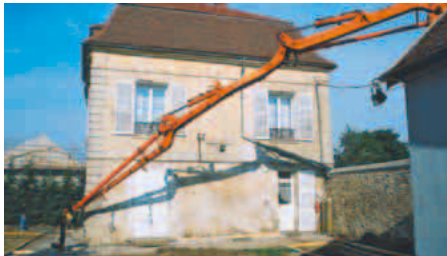
La flèche de 24 mètres sert de « pont tubulaire » et passe au-dessus du mur du jardin
